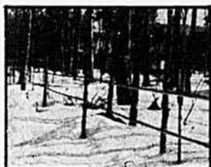
3 Deux conduits de 3/4", soutenus par du fil de fer et des poteaux, transportent la sève jusqu'à la cabane à sucre.
