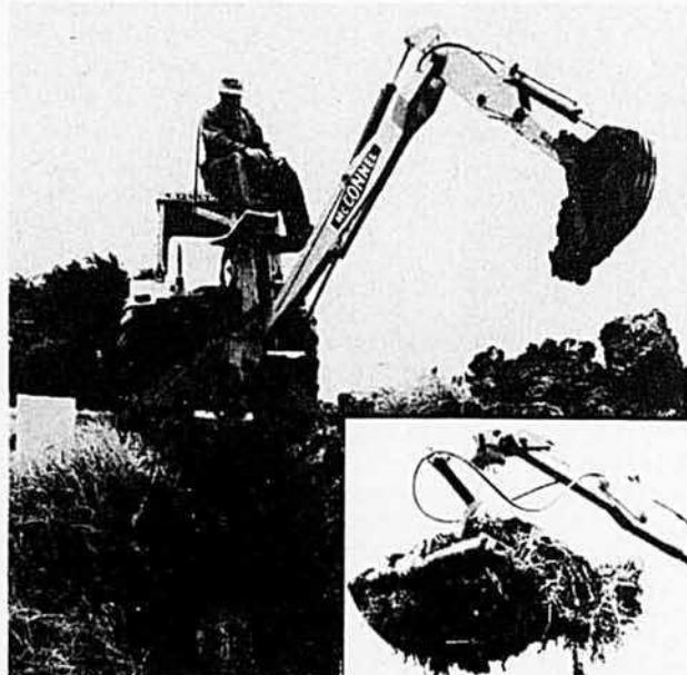
Tour à tour excavateur puis chargeur aux cent usages.
