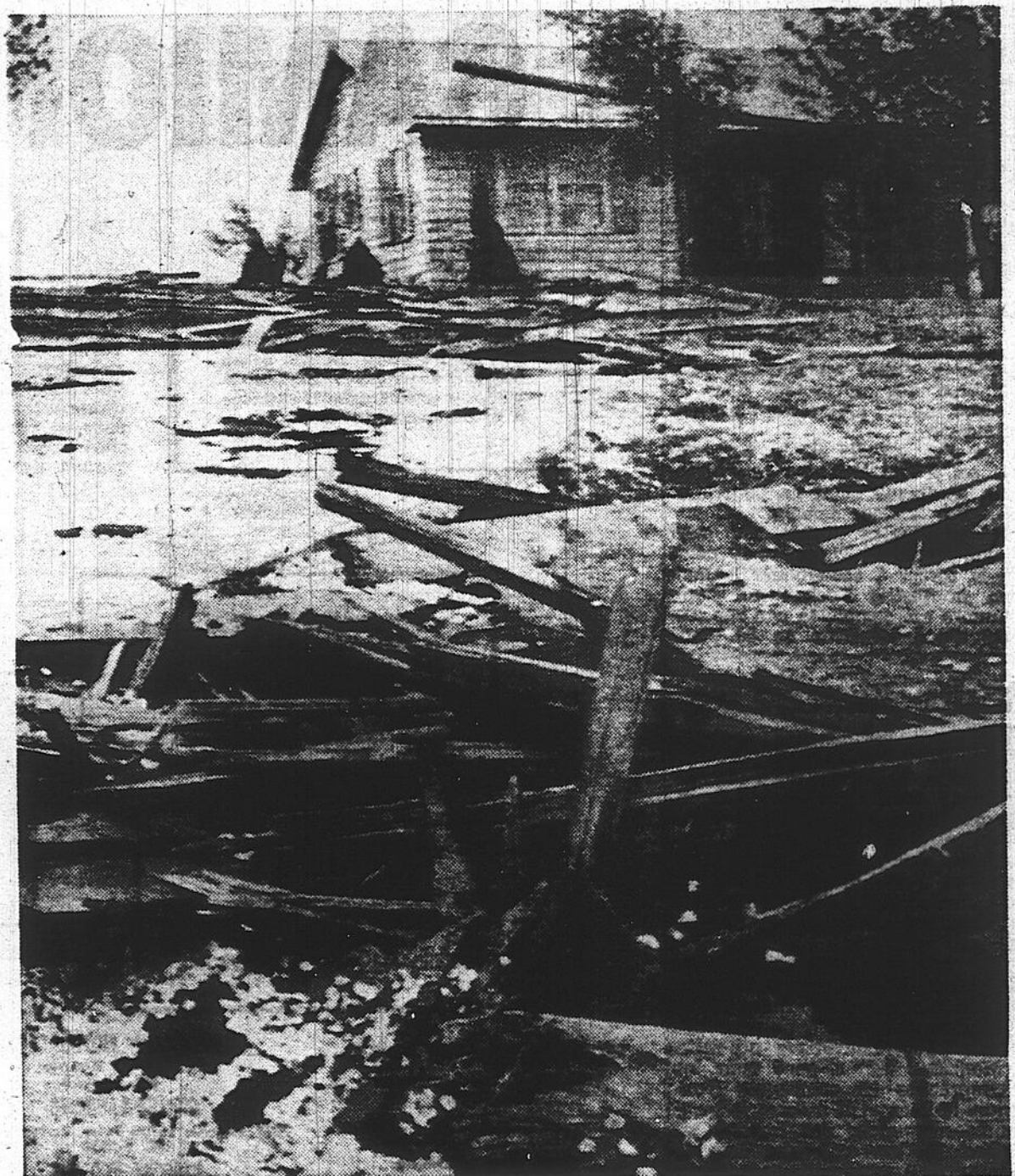
FORT COUP DE VENT — Un violent coup de vent qui a soufflé à Hutchison, Kansas, a arraché le toit d'une maison, répandant les débris jusque de l'autre côté de la rue. Les grains blancs qu'on aperçoit au premier plan sont le gravier de la couverture. (Fac-similé UPI — "Montréal-Matin")
