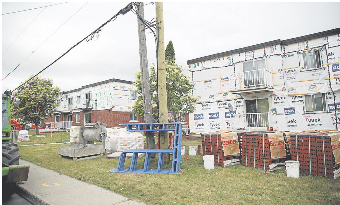
Depuis mai et jusqu'à la fin août, les deux immeubles feront l'objet d'importants travaux visant à stabiliser leur structure, en plus de rénovations d'envergure. Des travaux dont la valeur frôle les trois millions de dollars et qui doivent s'échelonner sur 16 semaines. — LA VOIX DE L'EST, JULIE CATUDAL
