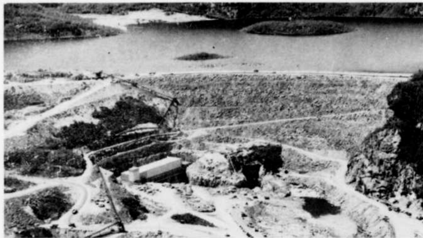
La centrale d'Outardes 4, dont le premier groupe générateur fut mis en service récemment, est construite au pied d'un barrage en enrochements qui barre la rivière aux Outardes à 58 milles de son embouchure.
