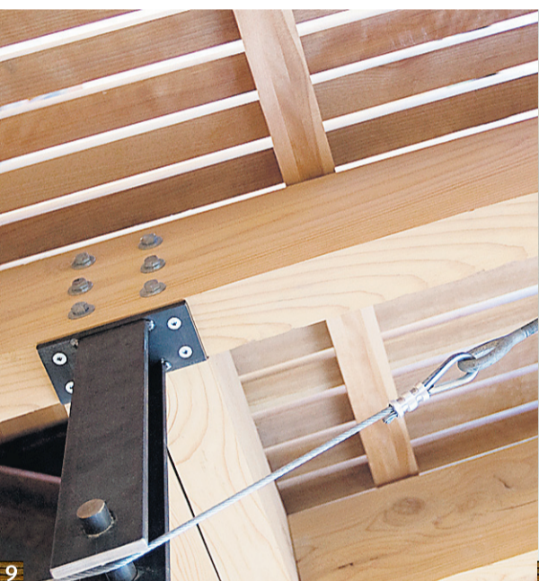
9 10 11 Plusieurs éléments de la structure n'ont pas été camouflés. Au centre: un passe-plat en contreplaqué de merisier. À droite: une poutre lamellée-collée soutenue par deux colonnes d'acier.
