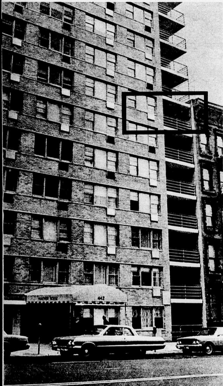
L'appartement 7-C, vers le coin supérieur droit de la photo, occupe un des angles de l'immeuble Hanover.
