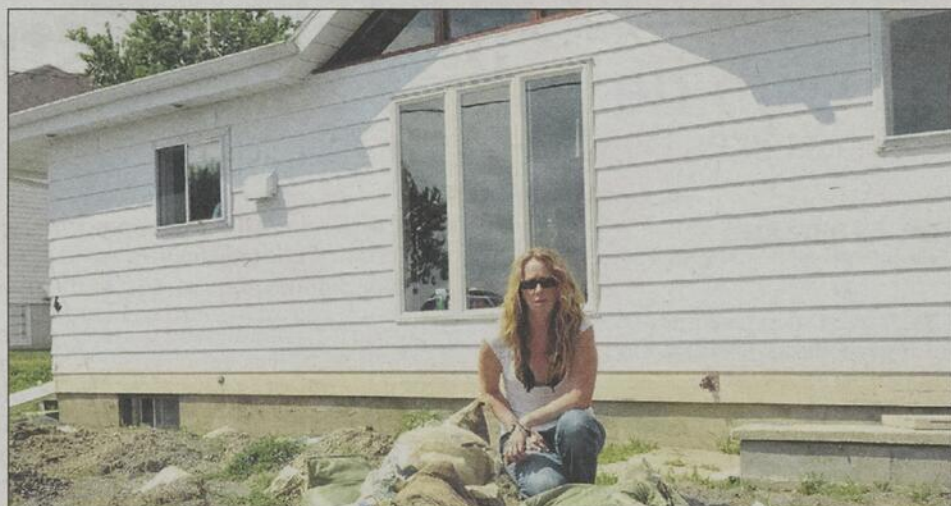
Devant l'ampleur des dégâts, Vicky Santerre est forcée de démolir sa maison. Elle ne peut le faire sans l'adoption du décret autorisant la reconstruction en zone inondable.
