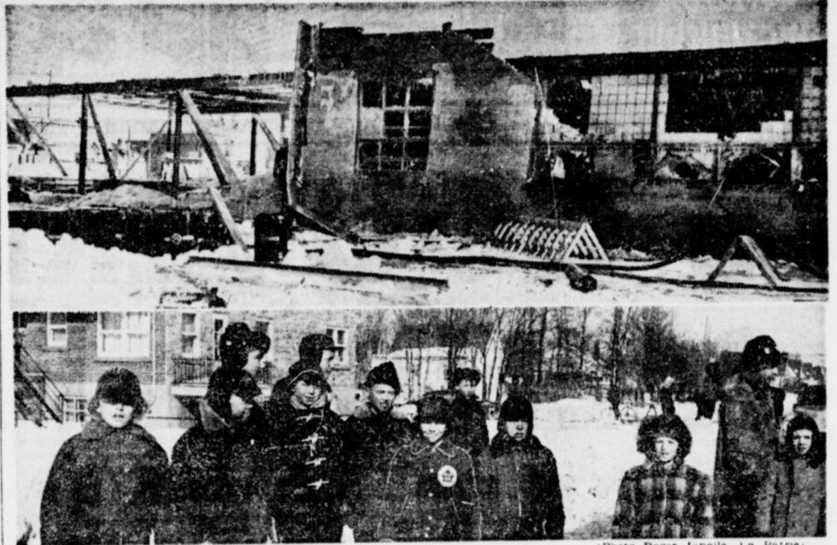
VIOLENT INCENDIE A LONGUEUIL. — L'Ecole Lemoyne, institution anglo-protestante de Longueuil située boulevard Lemoyne, angle de la rue Montarville, a été rasée de fond en comble vendredi matin. Le feu a pris lorsqu'un soudeur qui fixait un rivet pour unir la nouvelle structure au corps principal de l'édifice a mis le feu avec sa torche. A huit heures du matin, les flammes faisaient rage. Les élèves des trois classes (90 en tout) étaient encore à déguster leur déjeuner lorsque l'école prit feu. Les sapeurs-réguliers (24 hommes) et les volontaires ont déversé un million de gallons d'eau. Les pompiers étaient sous les ordres du directeur de Longueuil, M. Antonin Dussault. Deux ailes étaient en construction. Le toit et la majeure partie de la construction étaient en bois. Le principal de l'école est M. Don McNaughton. Les élèves en ont été quittes pour déposer leurs serviettes et regarder le spectacle qui fumait encore à midi. La perte est totale.
