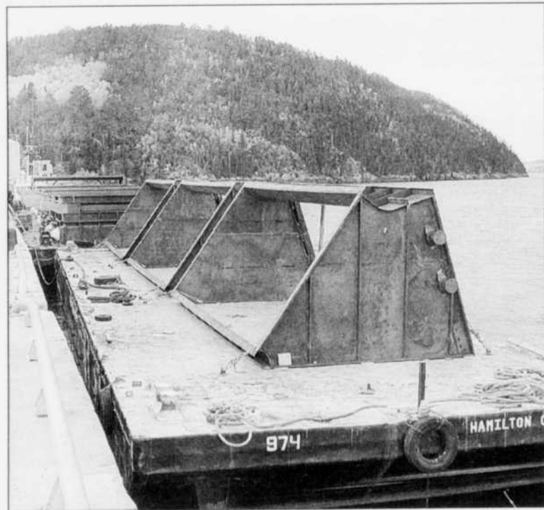
CHARGEMENT - Une fois les composantes de l'usine réalisées à l'atelier, elles sont acheminées et installées chez les clients. (Photo Sylvain Dufour)
