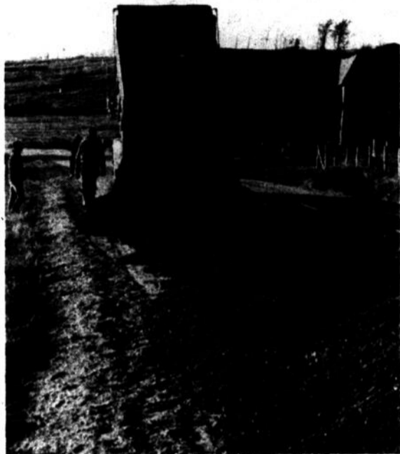
Le pavage de la route 263 entre Chester-Nord et Trottier devrait être terminé à la fin du mois d'octobre. Actuellement, les employés du ministère des Transports s'affairent à l'épandage du gravier concassé, première étape de ces travaux.
