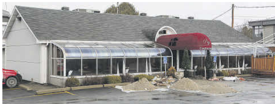
Le restaurant Pizz Contrecœur a subi des dommages importants à l'intérieur en raison d'un incendie jugé criminel survenu dans la nuit du 2 décembre. Photo Pascal Cournoyer | Les 2 Rives ©
