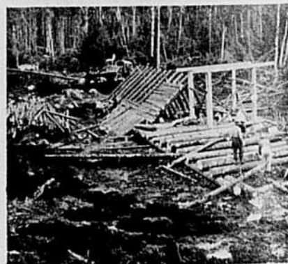
Construction d'une écluse (début) sur petit cours d'eau.
