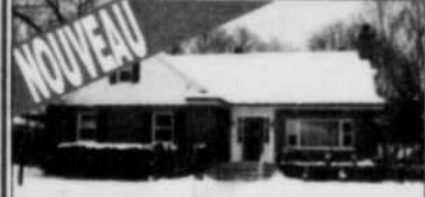
SILLERY, BELLE DEMEURE FAMILIALE! 2 foyers, moulures, bureau, bibliothèque, salle fam., 6 ch., 3 s. bains. Beau terrain orienté sud. Secteur convoité, voisin du Bois de Coulange. 399 000$
