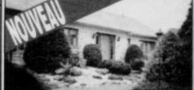
BEAUPORT, VASTE BUNGALOW aménagé avec raffinement et bon goût. Piscine couverte, foyer, solarium, cuisine équipée, toit cathédrale. Site exceptionnel avec vue sur la ville, sans voisin arrière. 239 000$
