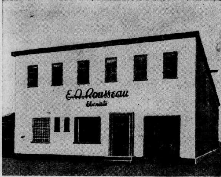
La récente construction qui abrite les ateliers à la Pointe-aux-Lièvres.
