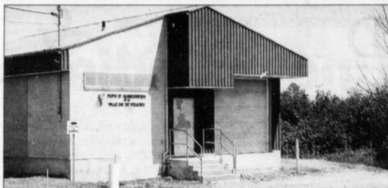
Le puits P3 génère 25% de l'eau potable de Saint-Félicien. Son bris nécessite une restriction de l'arrosage extérieur.
