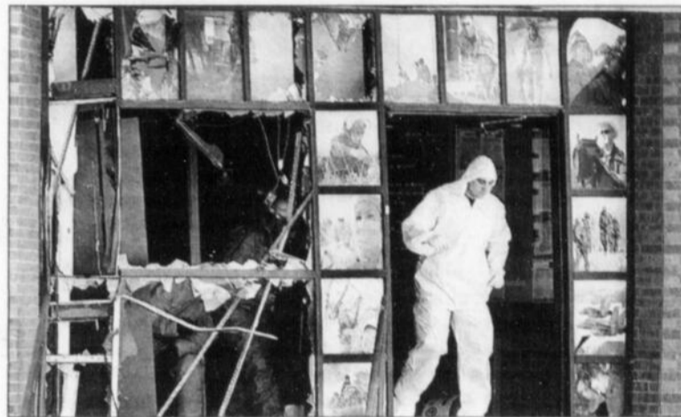
Les portes de verre du centre de recrutement ont été détruites par l'explosion. Des escouades canine et antibombe ont été dépêchées sur les lieux.
