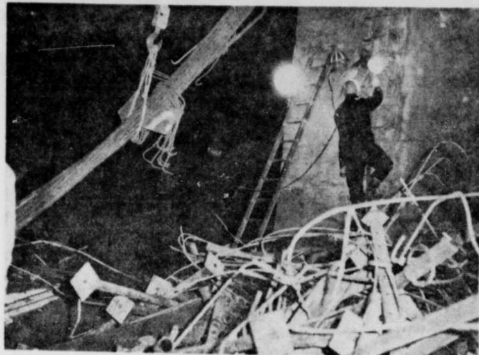
DEUX SAUVETEURS s'affairent à installer des lumières afin de faciliter le travail de leurs compagnons après la tom-
