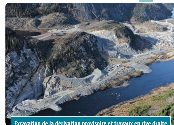
Excavation de la dérivation provisoire et travaux en rive droite
