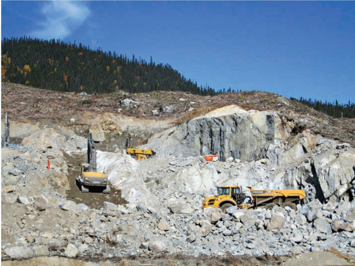
Forage et transport de roc au poste de départ de la Romaine-3
