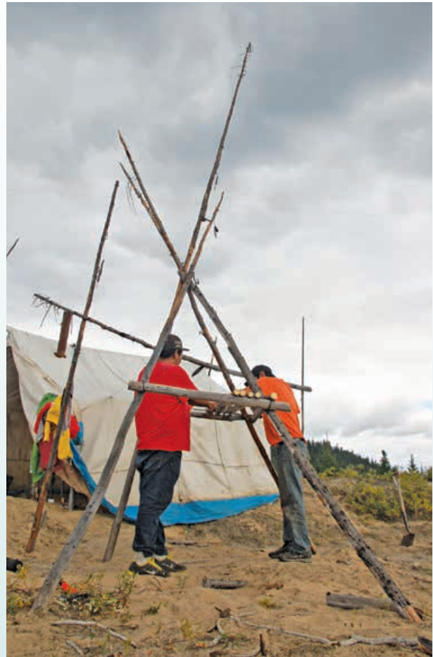
Installation d'un fumoir
