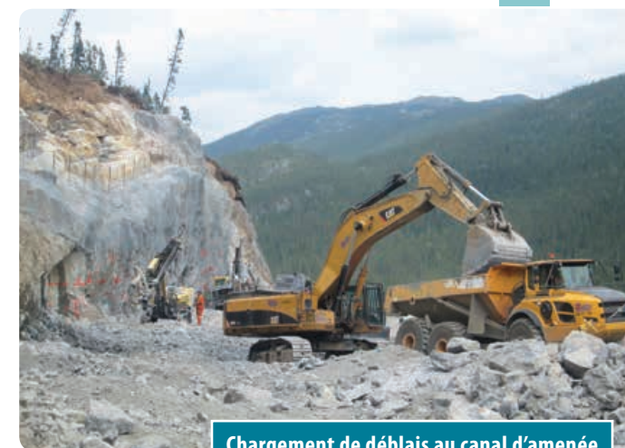
Chargement de déblais au canal d'aménée
