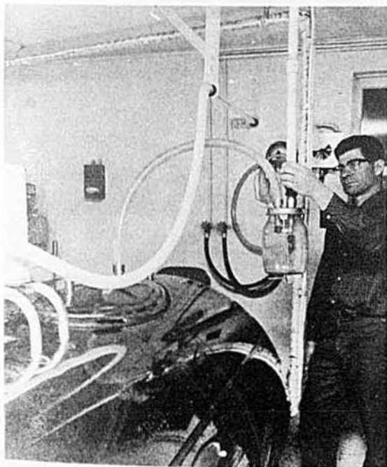
Le lait est dirigé dans le refroidisseur en vrac par un système semi "pipe line". Ce refroidisseur de 500 gallons a tout récemment été changé pour un autre de 800 gallons.
