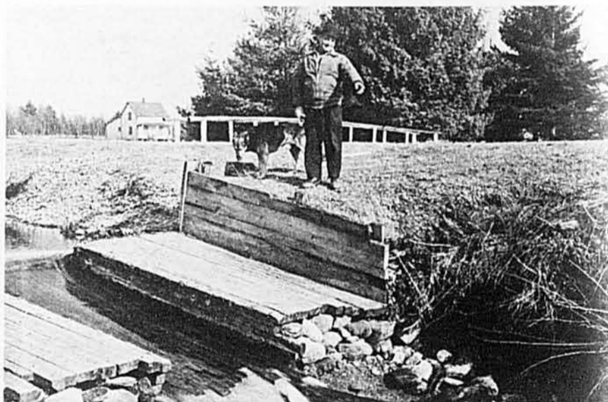
M. Dionne indique l'emplacement du tuyau d'alimentation dans le ruisseau.
