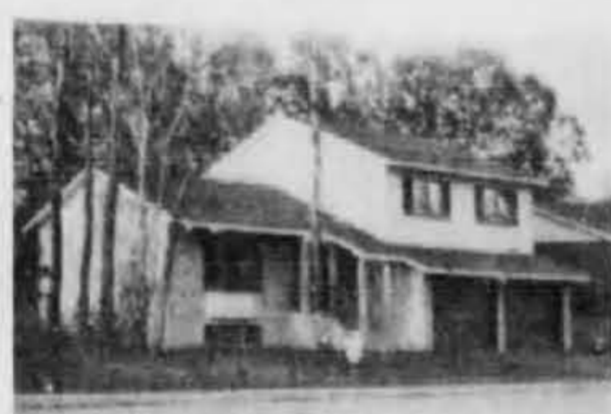
BROSSARD: $131,000 [436] 7 pièces, 3 chambres, salle familiale, foyer, salle à manger. Faut voir! Mary Ann Turner 672-6020, 765-0331
