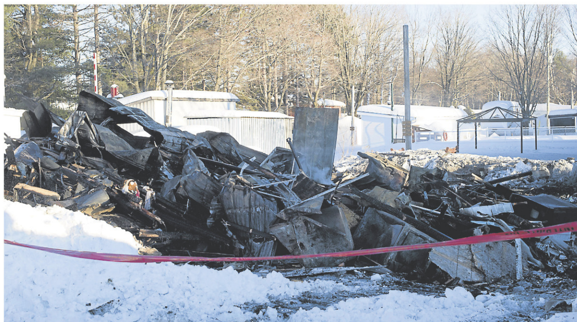
Voilà tout ce qui reste de la résidence des propriétaires du camping Les lions d'or et du bureau d'accueil de leur entreprise. — PHOTO SYLVAIN MAYER
