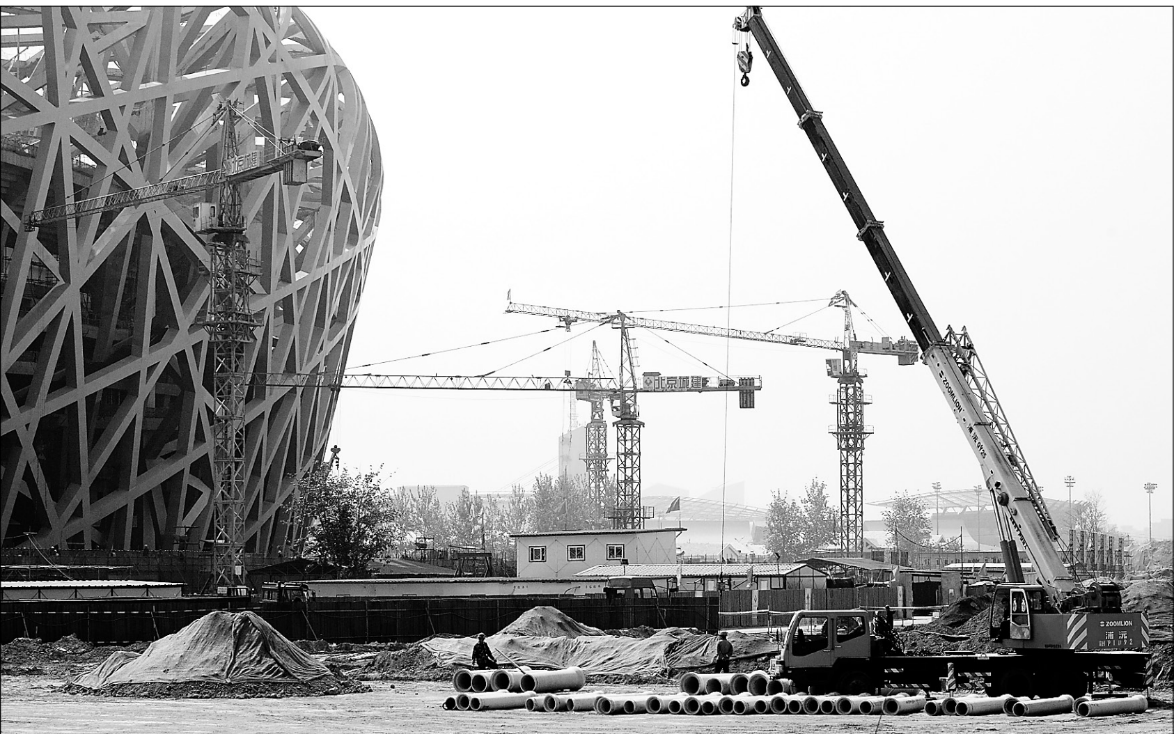
La construction du Stadium national vont bon train à Pékin, lieu qui accueillera les Jeux olympiques. Il se tiendront du 8 au 24 août 2008.
