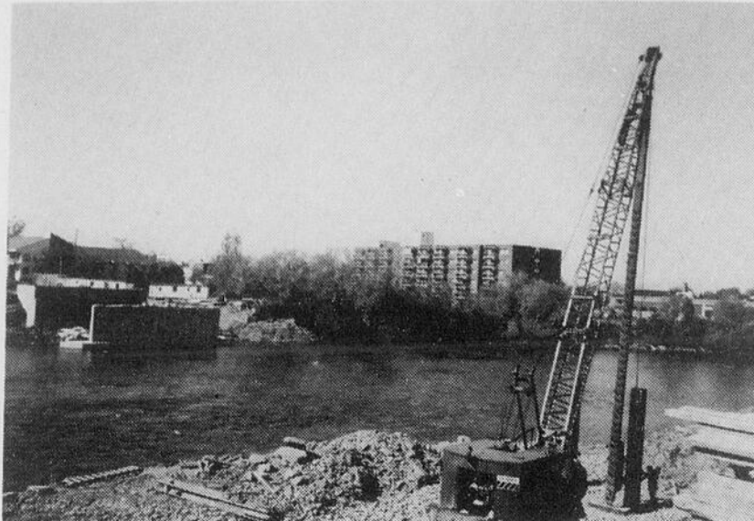
Le chantier du projet de l'axe nord-sud sur la rivière St-Charles; selon le candidat Jean-St-Onge, ce projet qui s'imposait devrait marquer un temps d'arrêt important pour ces projets coûteux et en même temps un répit pour le payeur de taxes. (Photo Le Soleil)
