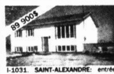
I-1031. SAINT-ALEXANDRE: entrée split, construction 1986, 3 chambres à coucher, planchers parqueterie partout, armoires mélamine, îlot central, terrain 88 200 pi carrés, elle est pour vous! Monique Cousineau
