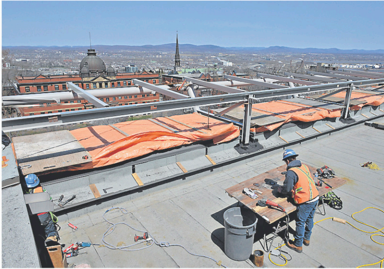
Depuis le toit du Grand Théâtre, la vue est magnifique sur les montagnes du nord... et sur les premiers panneaux de verre géants qui ont été installés.
