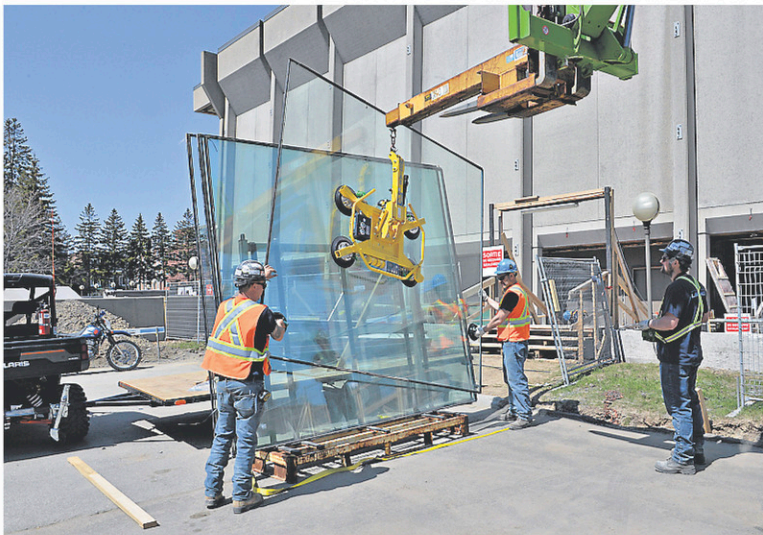
Chacun des 900 panneaux de verre qui envelopperont l'édifice pèse autour d'une demi-tonne.
