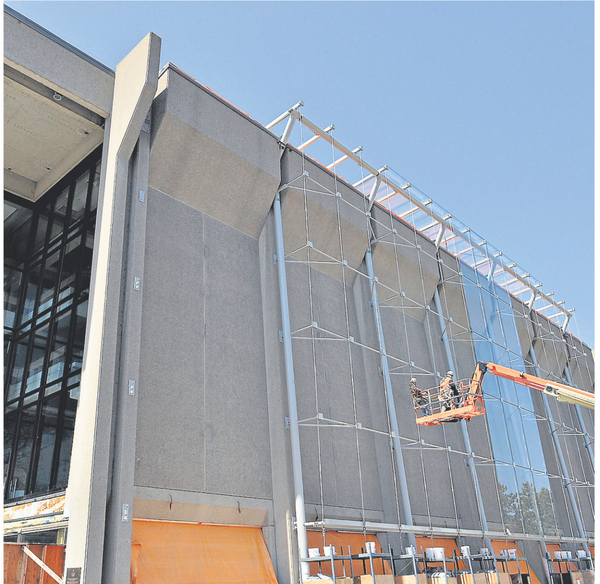
La structure est ajustée au millimètre près. Selon qu'il fasse soleil ou non, selon qu'il fasse chaud ou non, le métal qui soutiendra les façades s'étire ou rétrécit. — PHOTOS LE SOLEIL, PATRICE LAROCHE
