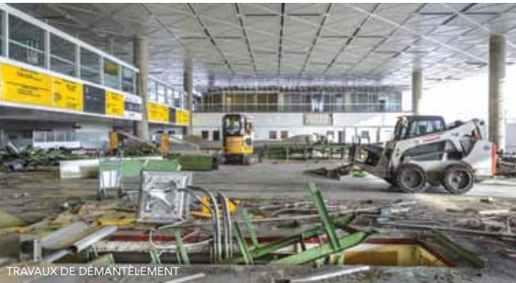
TRAVAUX DE DÉMANTÈLEMENT
