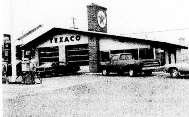
Station Service Lechasseur Texaco.
