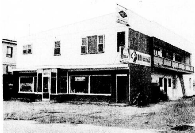
Fillion Enseigne Harvey Redistribution, Duval Rembourrage.
