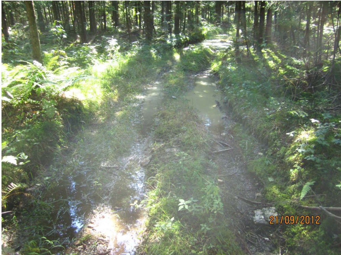
Figure 11 Présence d'ornières dans un chemin de débardage
