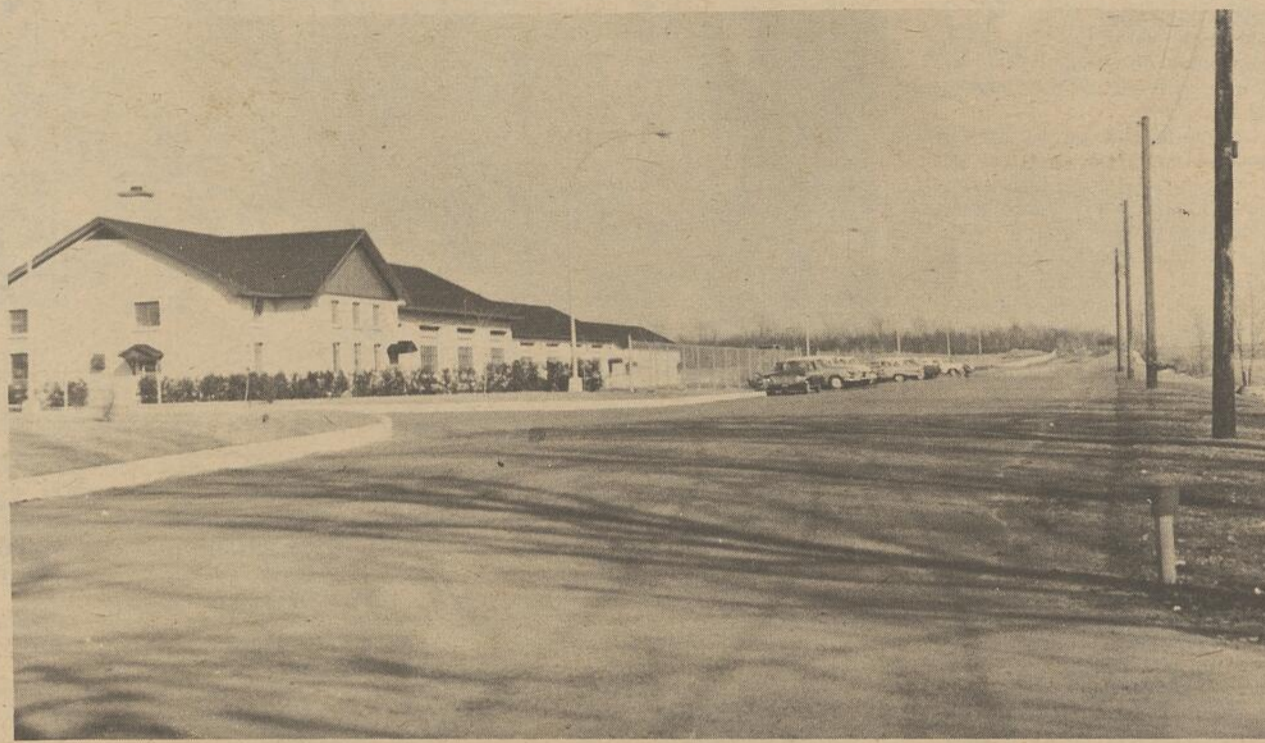
Vue d'ensemble des édifices de la voirie provinciale à Iberville, comprenant les garages, le bureau d'administration, et les entrepôts.
