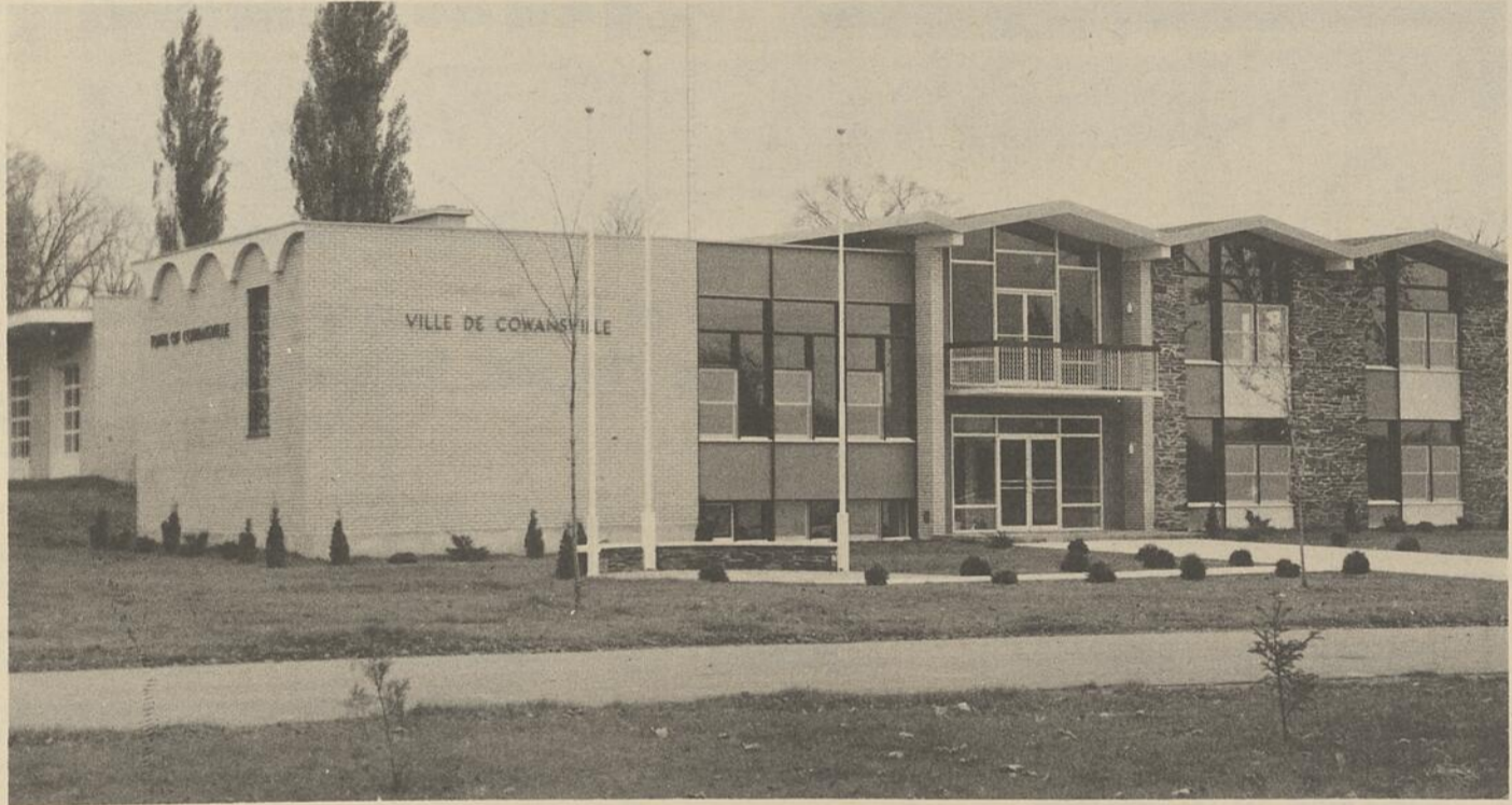
COWANSVILLE modernise graduellement ses immeubles, en plus de promouvoir son essor industriel. Voici le nouvel hôtel de ville, érigé il y a quelques années, pour remplacer un vieil immeuble qui ne répondait plus aux exigences de la municipalité.
