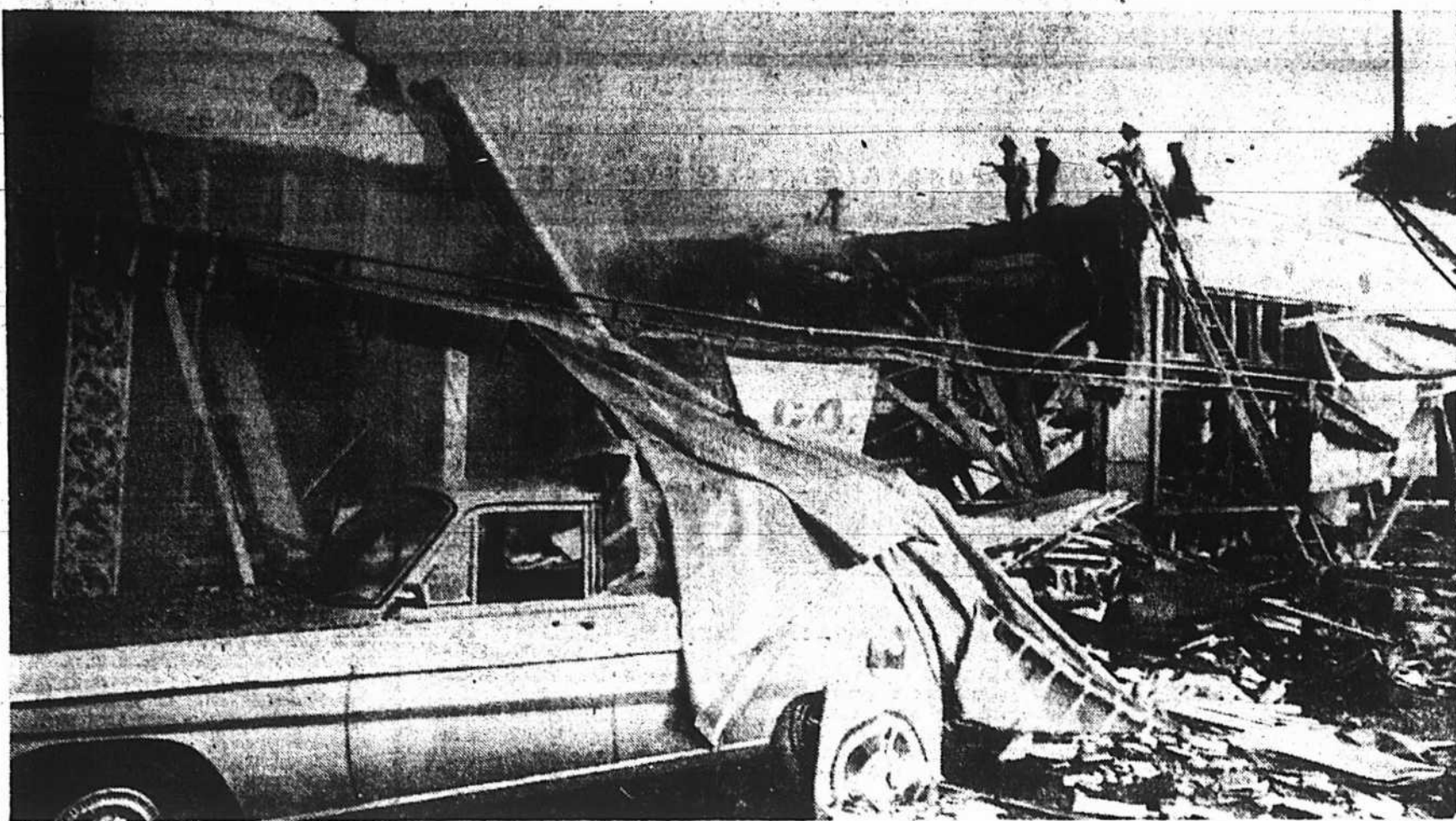
La plupart des établissements d'un centre commercial, à Miami Beach, ont été détruits quand une explosion suivie d'un incendie s'est produite. Les pompiers de toutes les casernes se sont rendus sur les lieux pour combattre les flammes.
