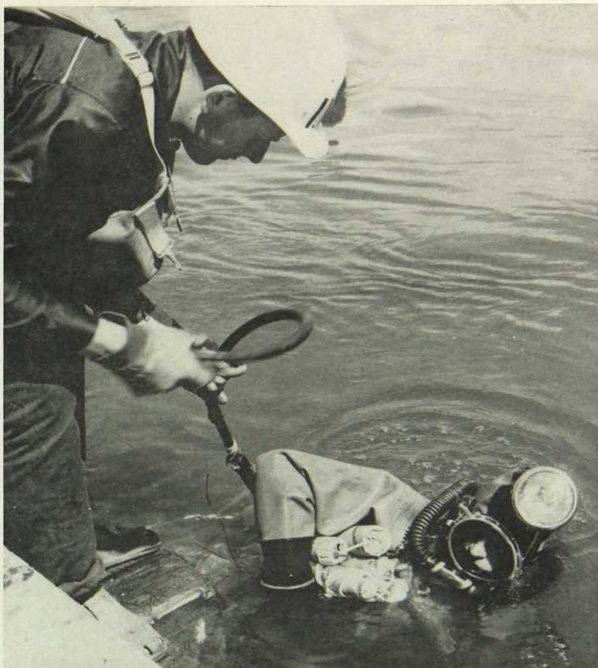
Un plongeur descend placer une charge de dynamite à l'endroit désigné après étude des plans du bateau.
