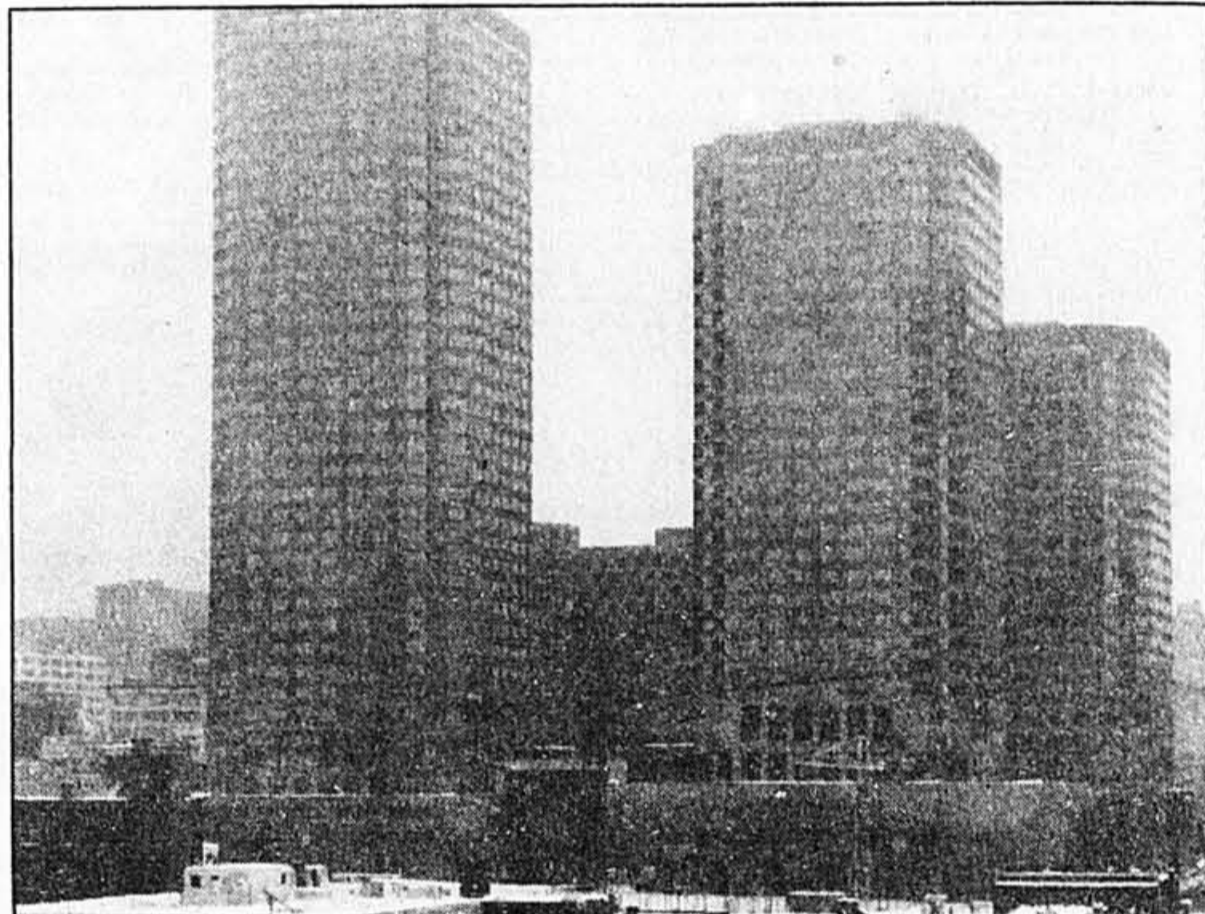
L'identité montréalaise recherchée par les entreprises va stimuler la nouvelle construction d'immeubles à bureaux même si il y a beaucoup d'espace disponible ailleurs.
