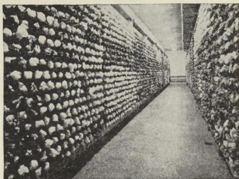
Une partie d'une des salles à température constante où les bouteilles contenant le bouillon ensemencé sont gardées pendant environ sept jours.
