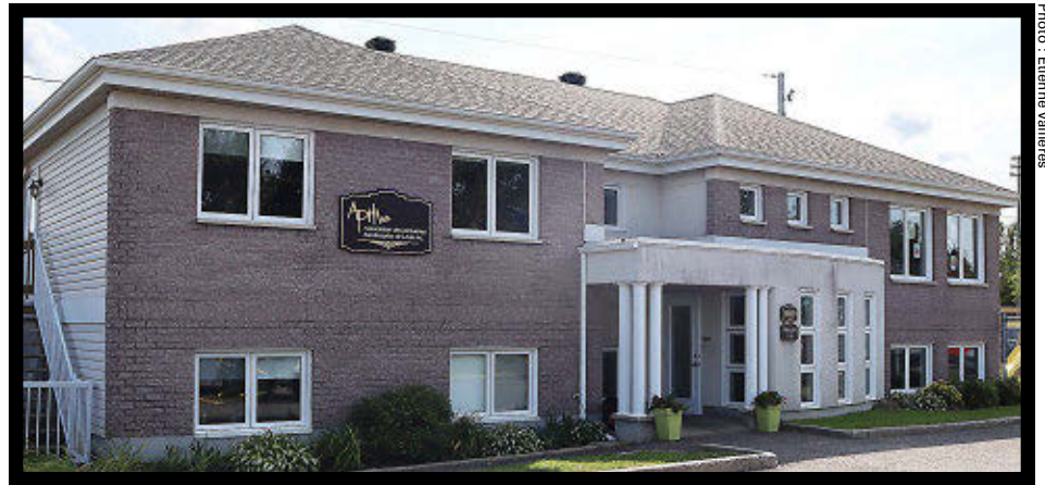
La devanture de la Maison de Quartier de Lévis, qui connaîtra des rénovations majeures.
