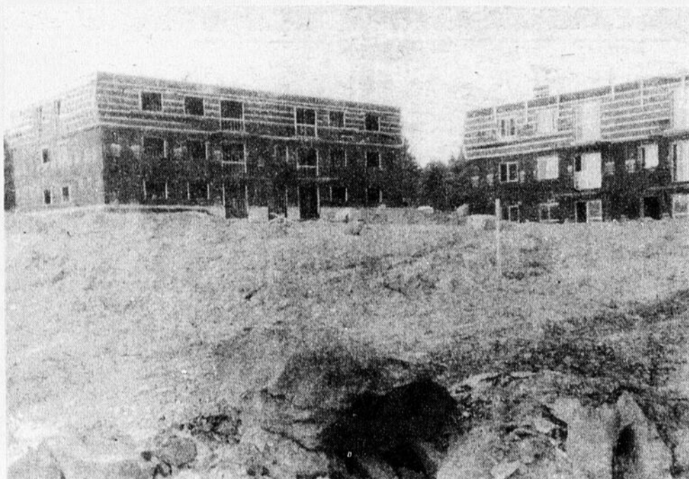
En 1979, 5 édifices à logements seront construits à St-Georges, plus précisément à l'arrière du Carrefour St-Georges. D'ici 2 ans, la construction de 224 logements est prévue.
