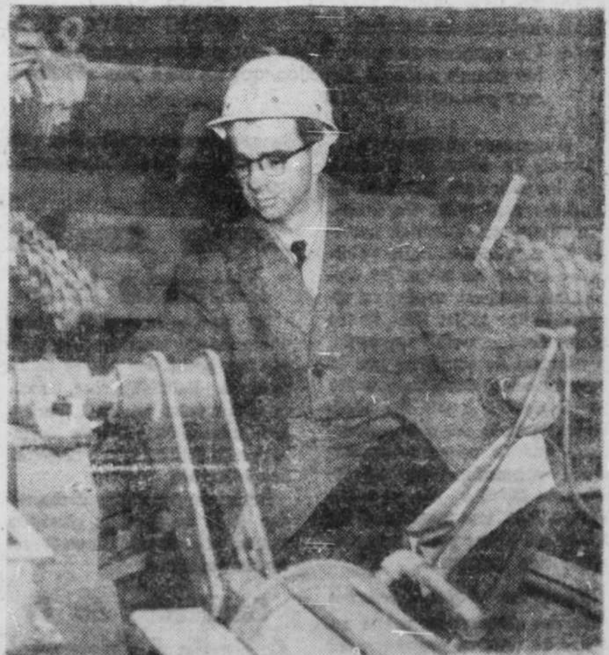
M. NAZAIRE GAUDREAULT, l'un des quatre estimateurs des usines de l'Alcan d'Arvida se rend constater de visu, certaines modifications à faire à une installation déjà existante. La visite des lieux permet de mieux prévoir les diverses étapes d'une modification.
