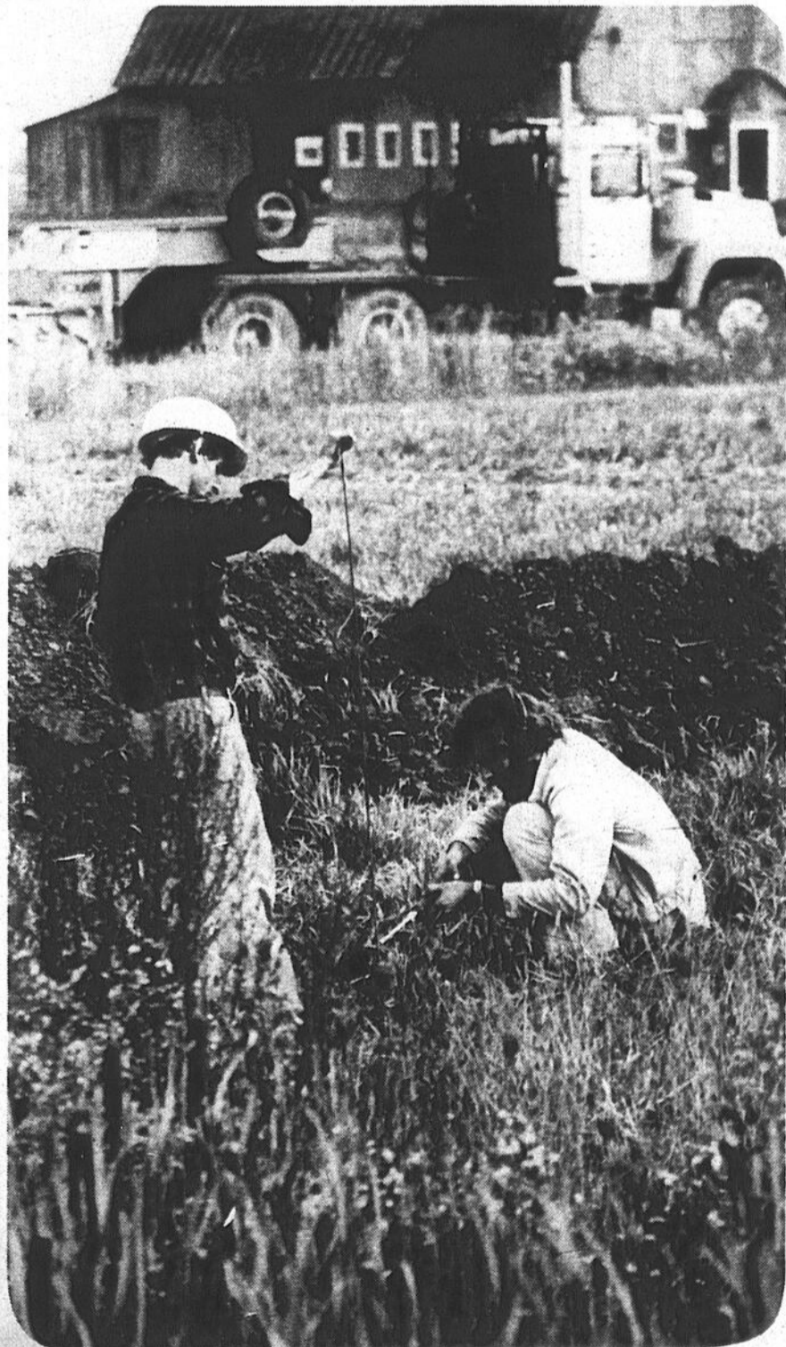
Les travaux de construction du gazoduc ont des conséquences nombreuses.
