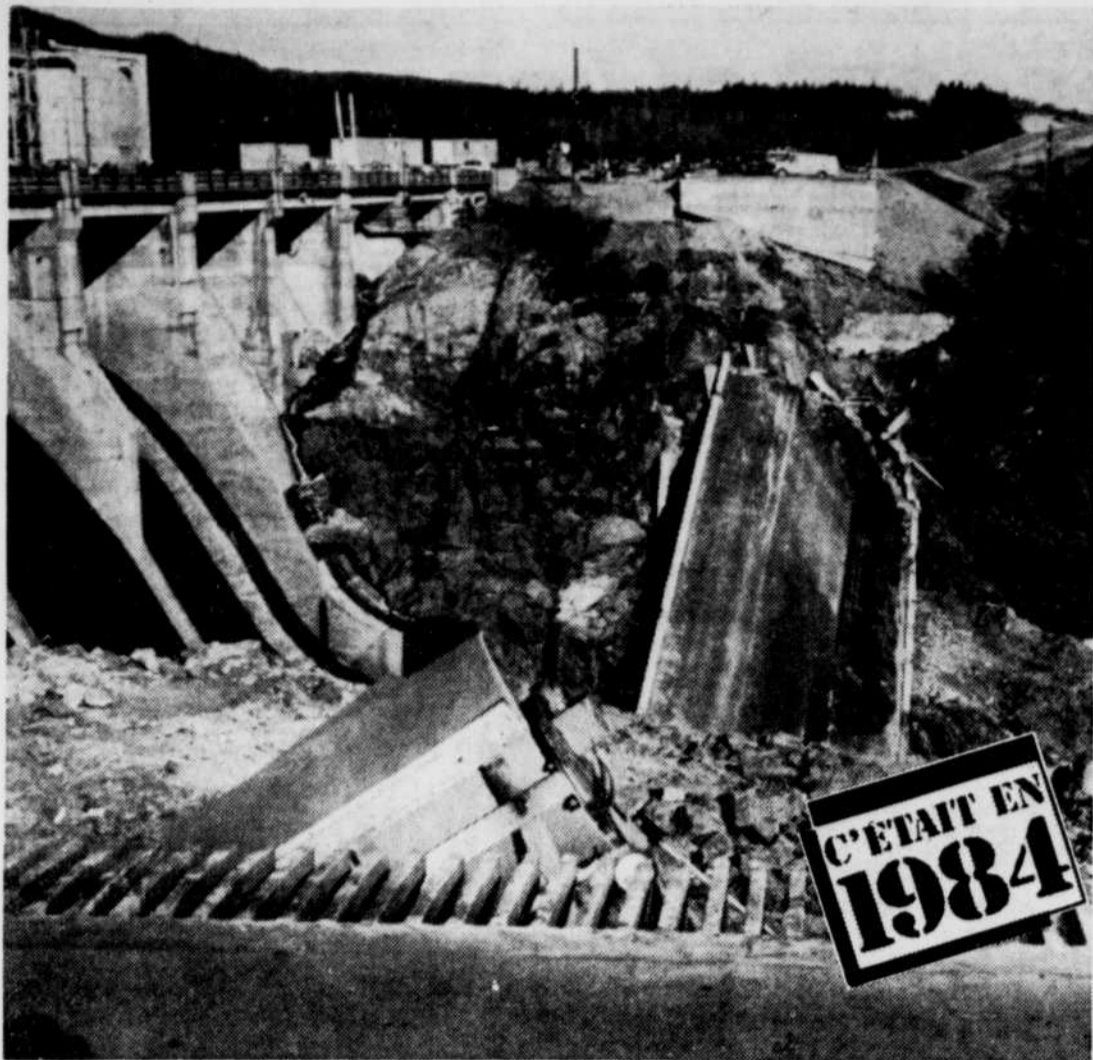
Six ouvriers sont morts le 30 octobre lors de l'effondrement du pont de la rivière Sainte-Marguerite, près de Sept-Îles.
