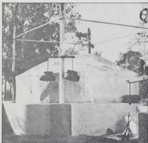
Cette installation de digestion anaérobique du fumier, construite en Inde par les agronomes de «Gobar Gas Research Station», peut produire quotidiennement près de 30 mètres cubes de méthane.
