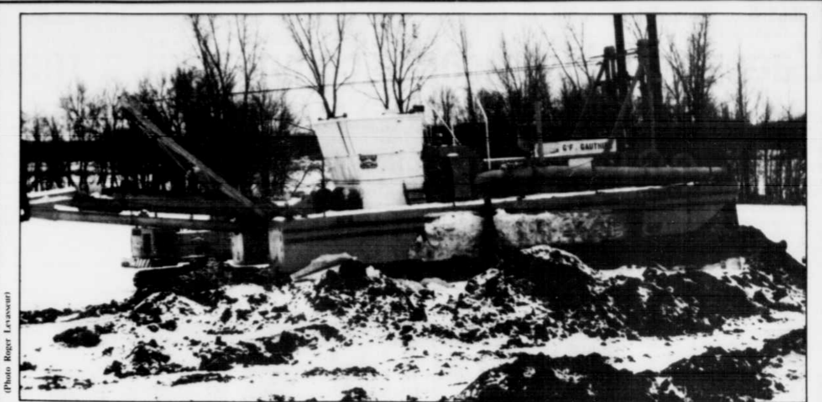
(Photo Roger Levasseur) L'entrepreneur G.F. Gauthier a juché son bateau-dragueur sur un amoncellement artificiel de terre, près de la rivière Bécancour. On a même placé des tiges de métal pour retenir le bateau lors de la débacle du printemps.
