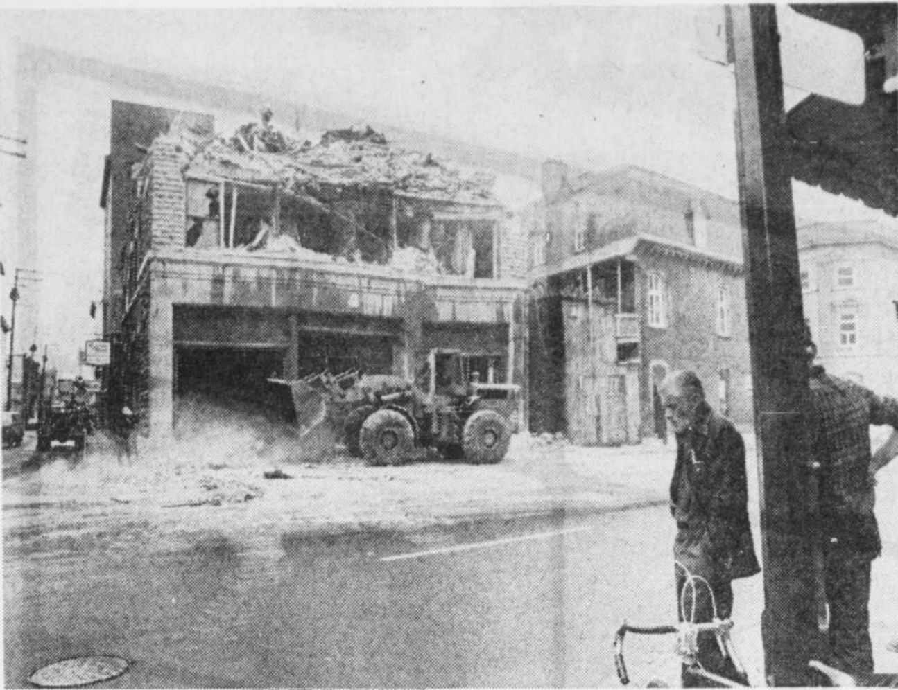
Le pic du démolisseur à l'oeuvre...
