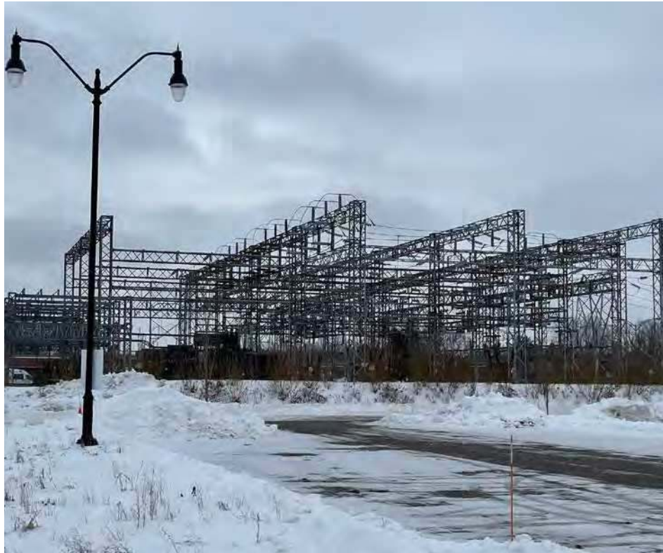
Le poste électrique d'Hydro-Québec est entouré d'une simple clôture. (Photo : Julien Dubois)
