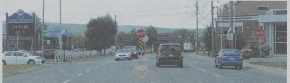
La réfection de la 1 re Avenue s'échelonne jusqu'au 22 septembre. (Photo Ville de Saint-Georges)
