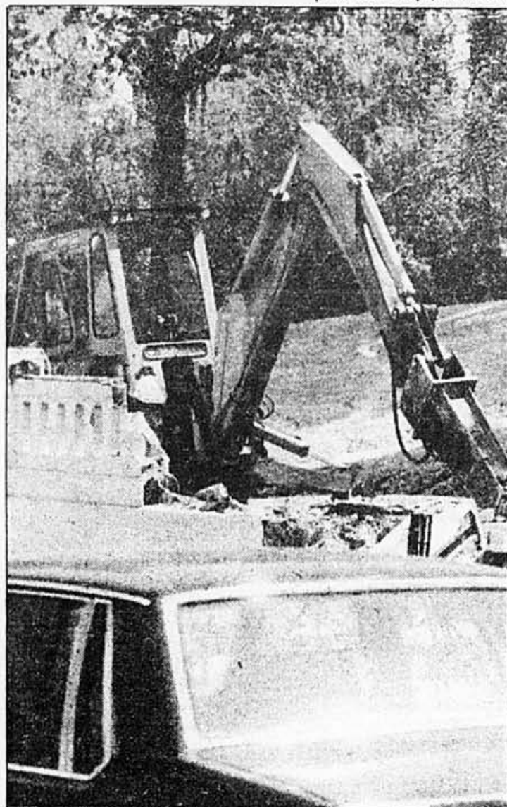
La Ville de Montréal est en train de démolir le tunnel piétonnier, sous l'avenue du Parc, face à la montagne, qui constituait autrefois la seule façon sécuritaire de traverser la large avenue.
