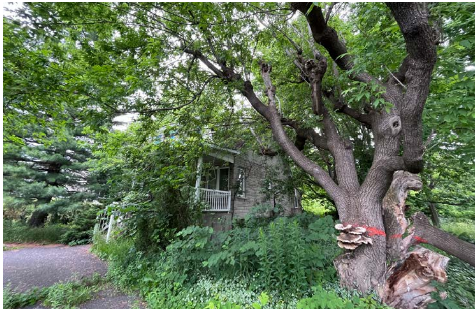
La Ville a acquis le 1422, rue Goyer et veut en démolir la maison. (Photo : Frank Jr Rodi)
