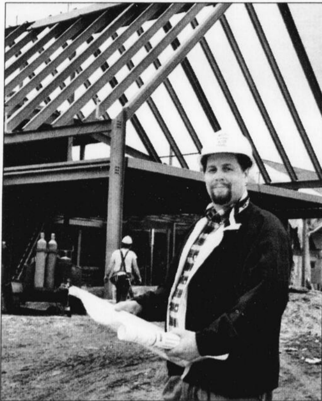
Éric Perreault, chargé de projet, suit la construction de très près et réalise l'un des plus grands défis de sa carrière.
