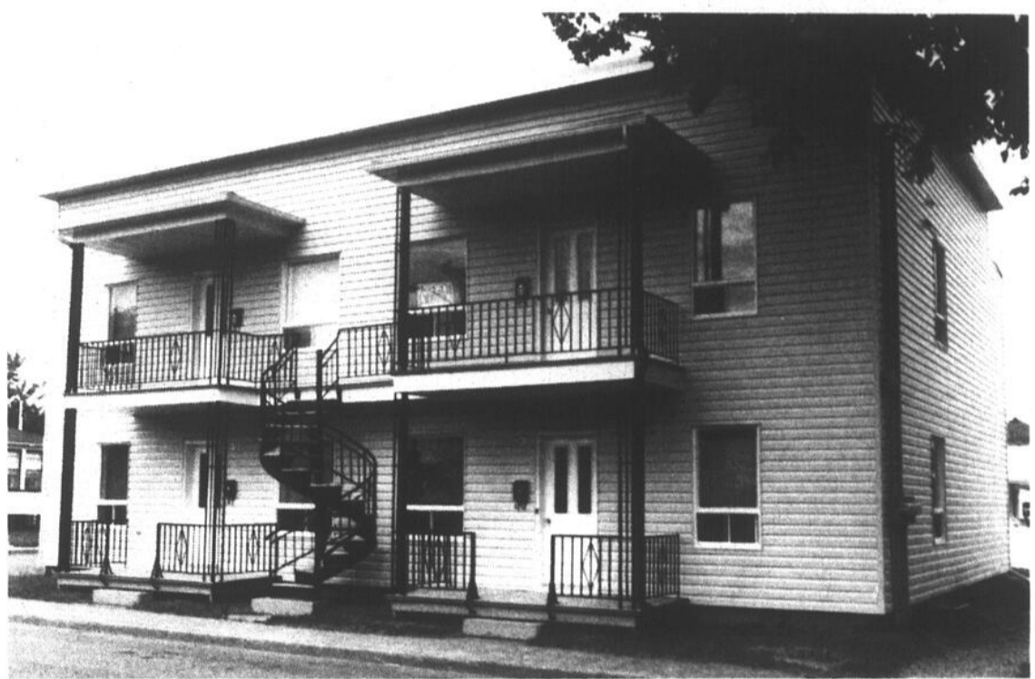
Une subvention de $6,350 a été versée au propriétaire de cet immeuble locatif dans le cadre du programme PRIL. Des travaux
