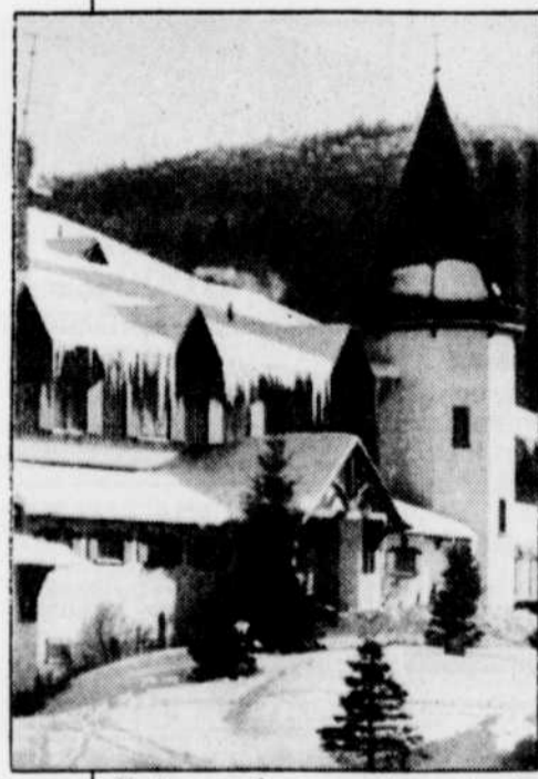
Endommagé par un incendie, le Manoir Saint-Castin dort depuis le mois de janvier 1991.
