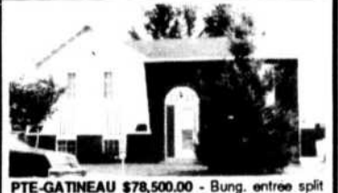
PTE-GATINEAU $78,500.00 - Bung. entrée split avec semi sous-sol fini bien éclairé, grandes pièces fonctionnelles. Cour clôturée, à distance de marche de l'hôpital et autres services. négociable. (7-85) MME FLO LAPIERRE 568-2720
