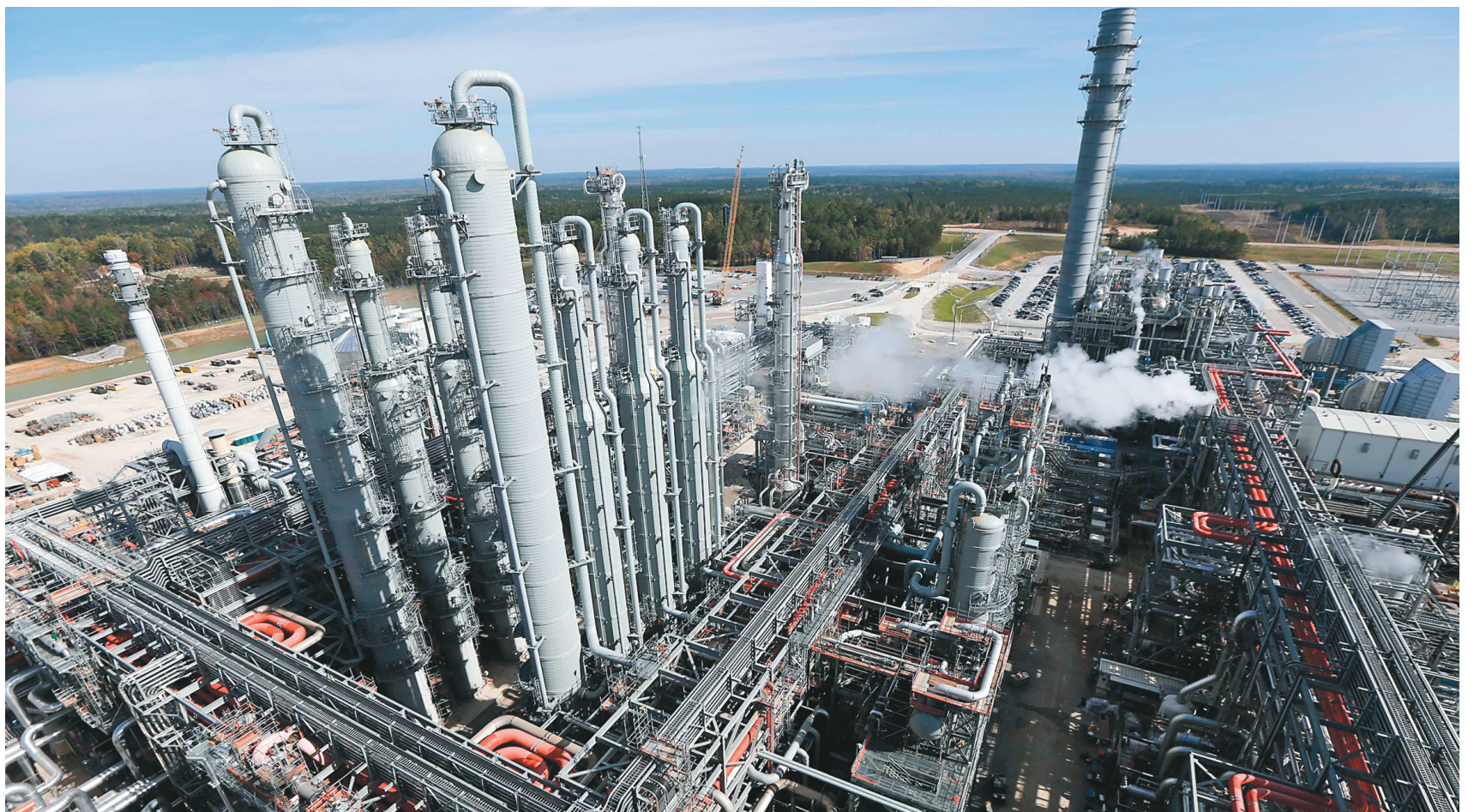
Cette usine de la Mississippi Power Company, située à DeKalb, au Mississippi, capte les émissions de CO 2 pour les enfouir dans le sol.
