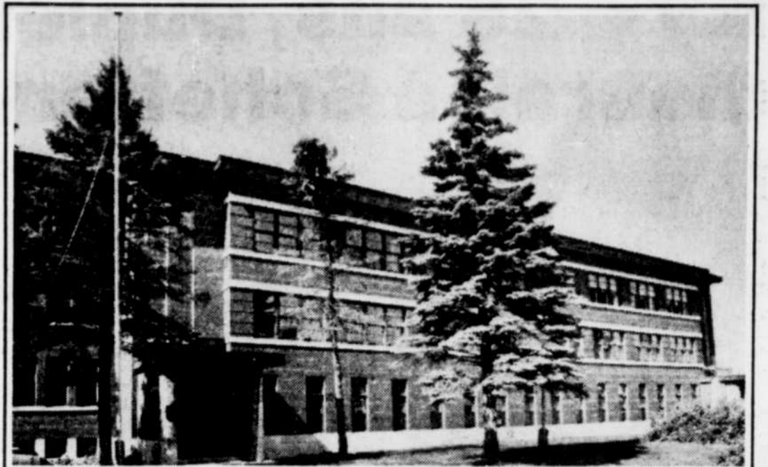
Désaffectée depuis un an, l'école primaire Boudreau, à Vanier, sert maintenant à accueillir les jeunes qui optent pour un retour à l'école.
